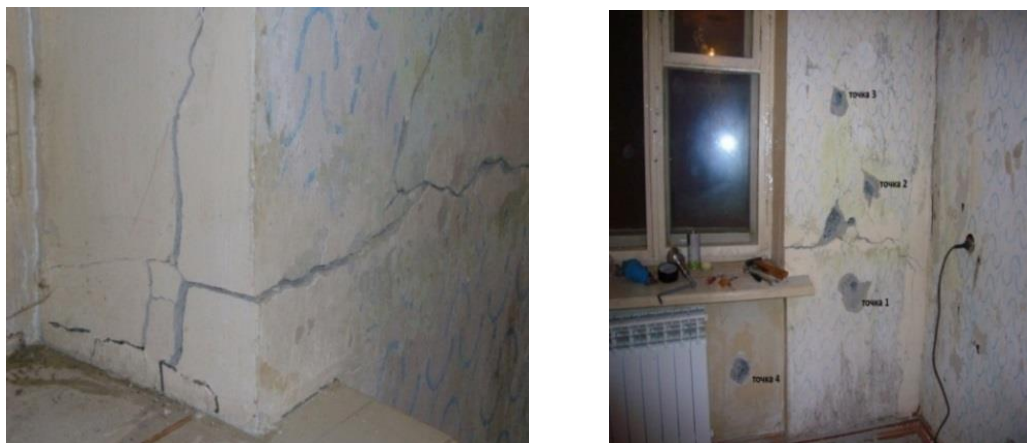
Рис. 5. Обследование стеновых блоков в жилом доме (г. Заполярный, ул. Космонавтов, д. 18). Общий вид стены в кв. 51 и вид стены с точками испытаний на прочность бетона
