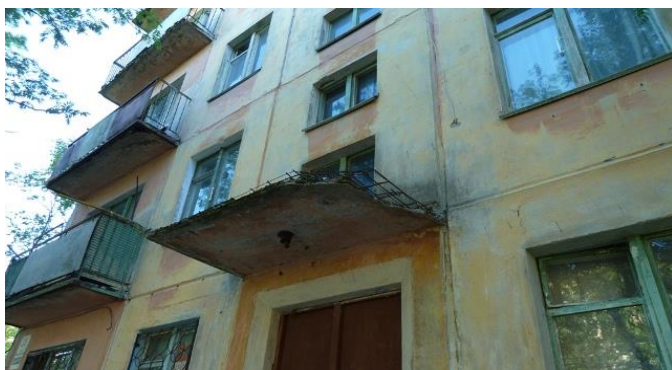
Рис. 2. Козырек подъезда № 1 (г. Апатиты, ул. Ферсмана, д. 25) до и после ремонта
