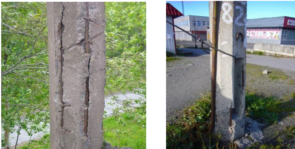
Рис. 4. Обследование опор линий электропередач
